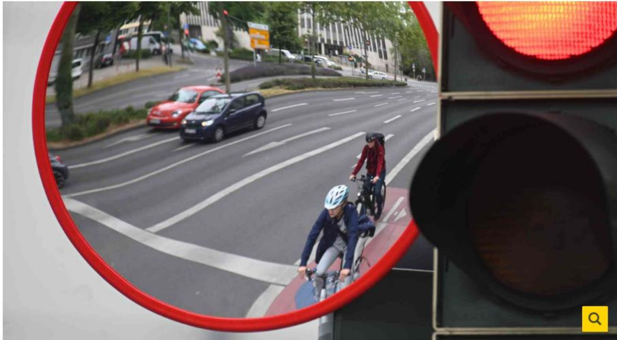
Ein zusätzlicher Rückspiegel: Wie hier an der Einmündung Kurbrunnenstraße/ Zollernstraße sollen Verkehrsspiegel besonders für Lkw- und Busfahrer den toten Winkel verkleinern. Foto: Harald Krömer
